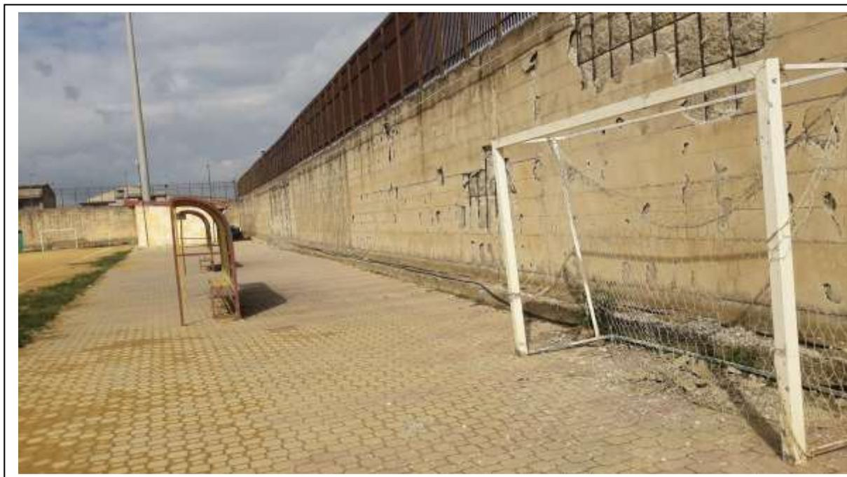
Nel muro di recinzione in c.a. debolmente armato, l'acqua piovana si è infiltrata nella struttura innescando un processo di carbonatazione ormai in fase fortemente avanzata, che ha espulso il copriferro in buona parte dei paramenti esistenti, aggredendo le armature presenti nella muratura. (vedi tavola 8: “Sistemazione generale - Interventi sui muri di cinta, spostamento cabina prefabbricata”).
